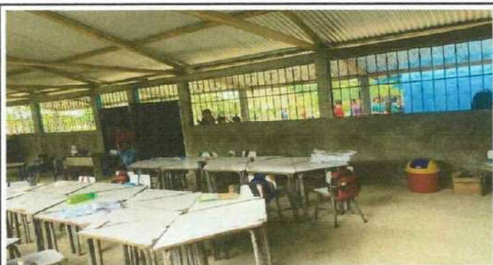
Foto 3: SUSTITUCION DE PISO DE CONCRETO POR PISO CERAMICO DENTRO DEL AULA
